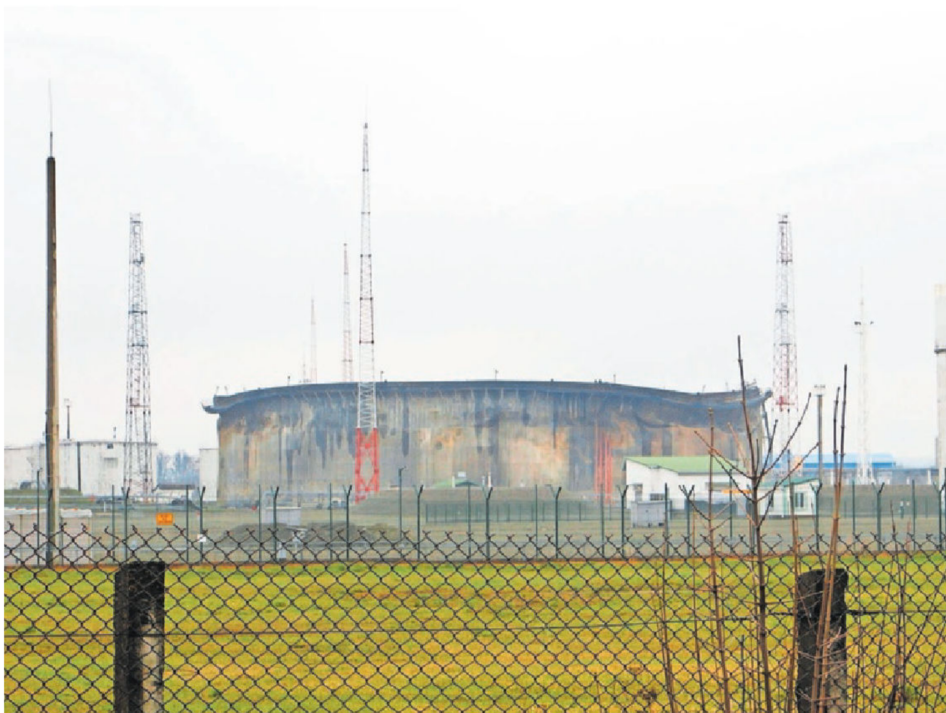
Depósito destruido por un dron ruso en la estación de bombeo del oleoducto Druzhba en Brodi, el miércoles. c. s.
